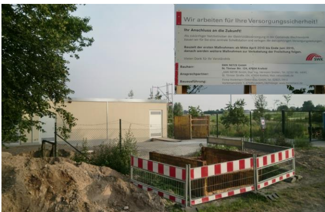
Hier die 10 KV-Schaltanlage
