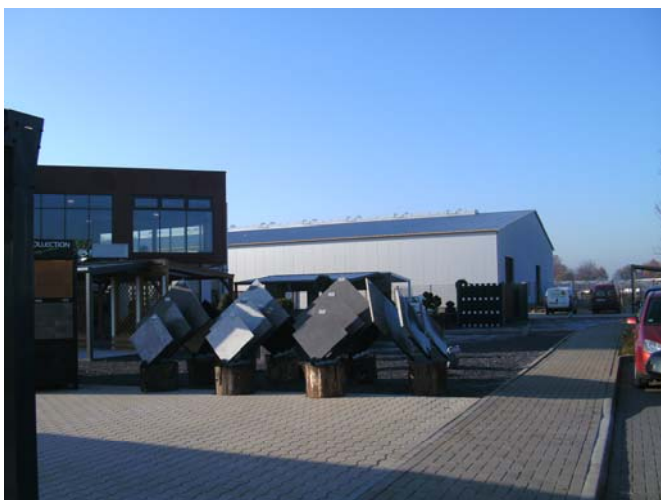
Im hinteren Bereich das neu errichtete Lagergebäude
