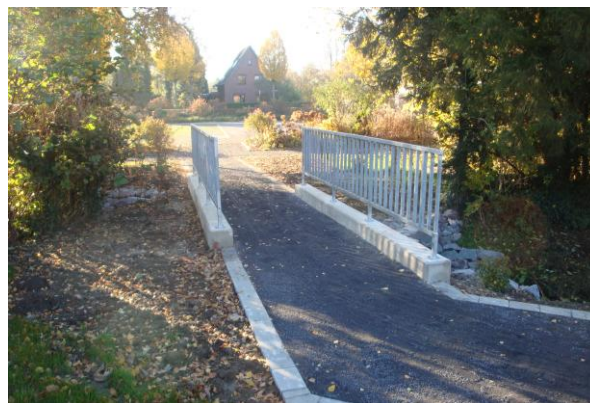
Neuer Durchlass am Bruchtorparkplatz
