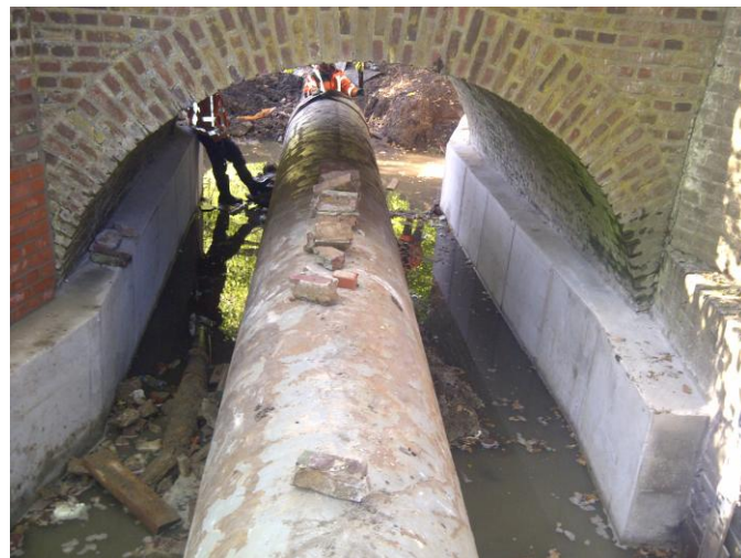
Bei den Arbeiten
