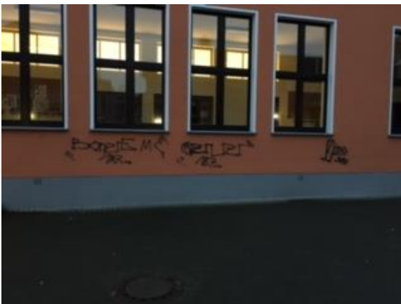
Graffiti-Schmierereien an der Fassade der Grundschule Wachtendonk
