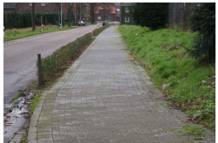
Hier der Radweg in ausgebautem Zustand
