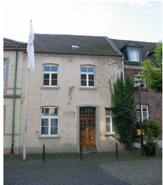
Das Haus Weinstraße 3 vor der Renovierung
