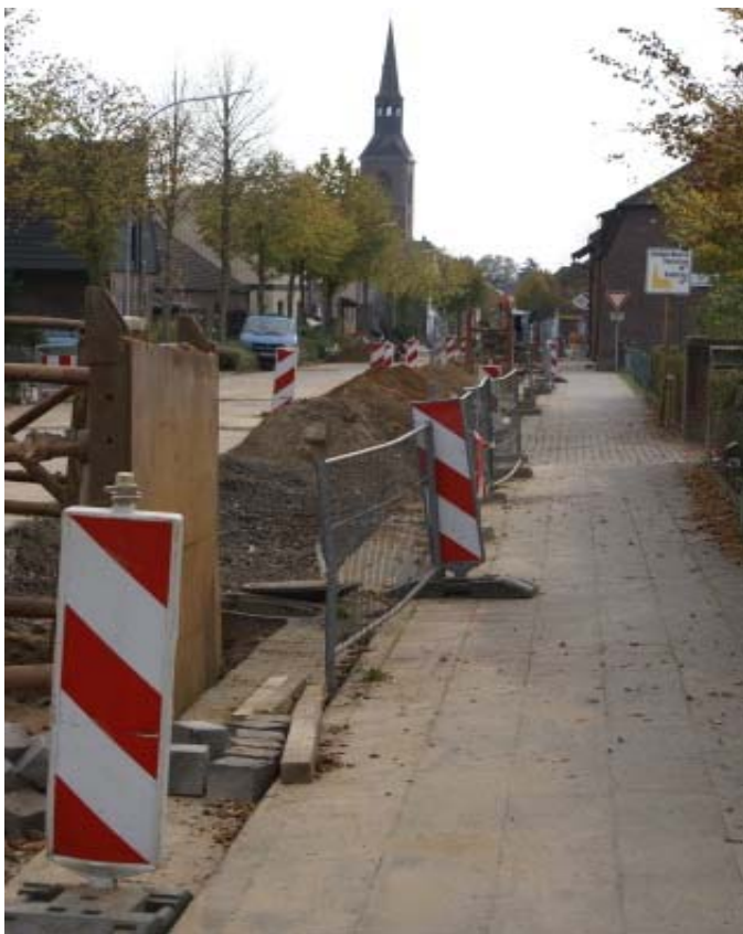
Während der Bauzeit
