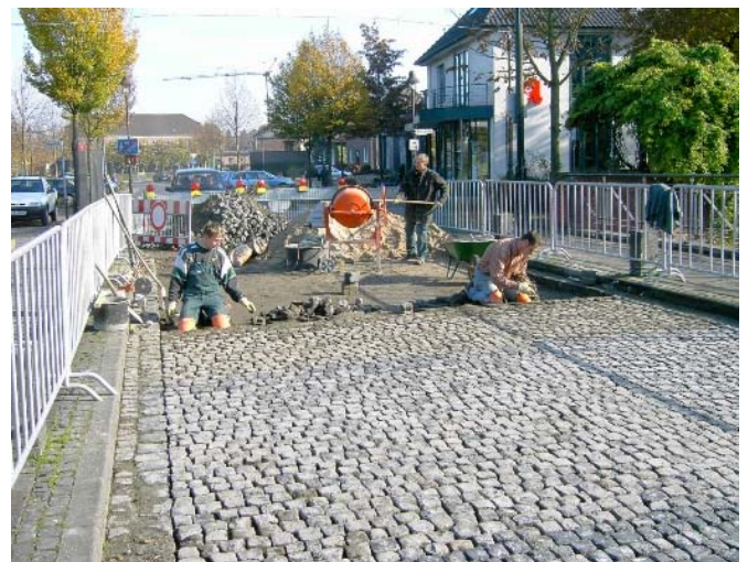
Die Arbeiten an der Niersbrücke
