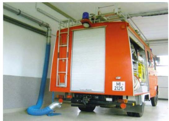
Muster-Absauganlage in Betrieb (Foto Katalog)
