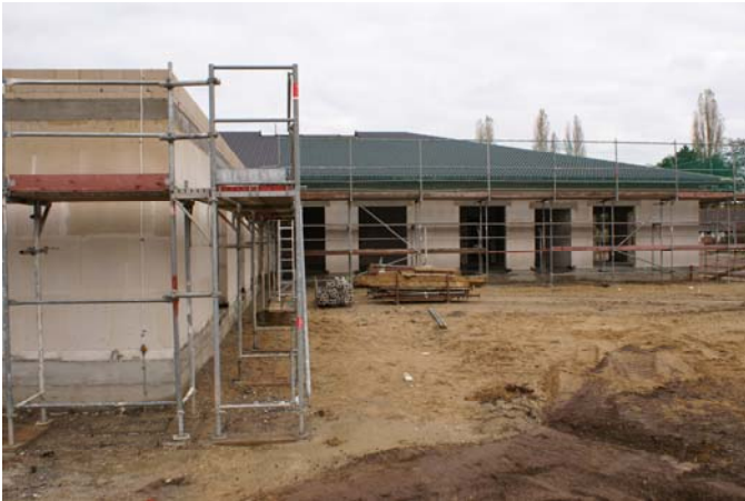
Im Bau: Seniorenresidenz „Im Hagenland“
