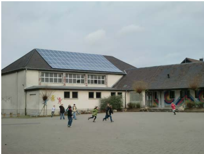
Photovoltaikanlage auf dem Dach Grundschule Wachtendonk
