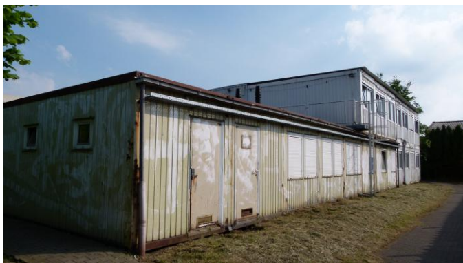
Die derzeitige Unterbringung in den Wohncontainern ist nicht akzeptabel.
