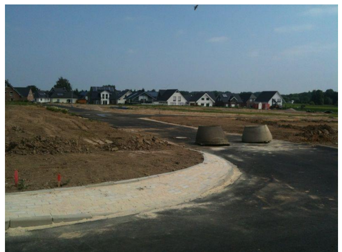
Erschließung des zweiten Bauabschnitts „Östlich Kuckuck“
