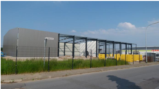
Es entsteht eine neue Montagehalle.
