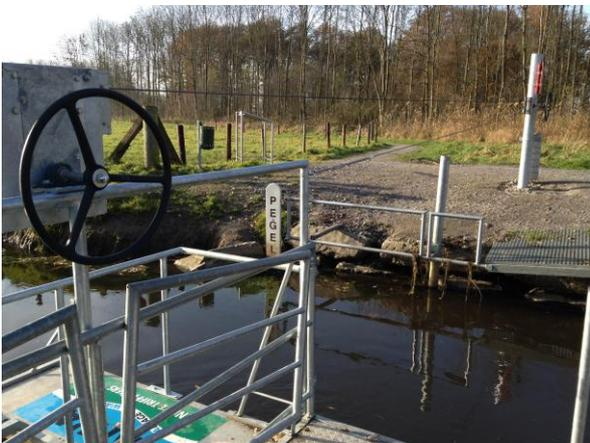
Die neue Funktion mittels Kurbelrad
