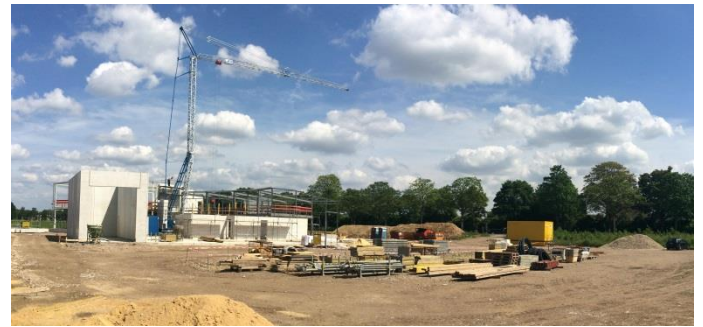
Die Bauarbeiten schreiten voran
