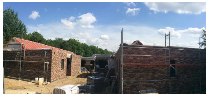
Die Bauarbeiten schreiten zügig voran.
