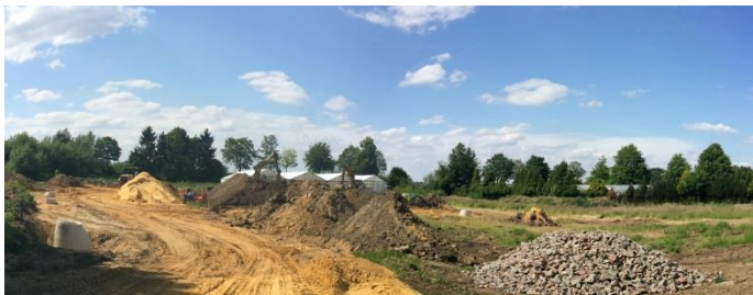
Die Erschließung im Baugebiet „Niersaue“ ist in vollem Gange
