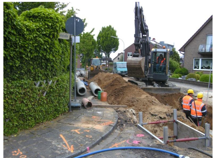
Der Schlecker Weg wird ausgebaut
