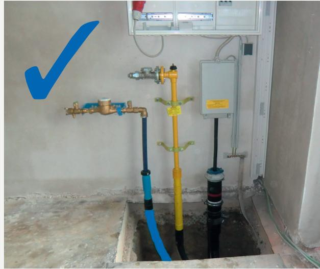
Abb. 1: Aussparung in der Bodenplatte
